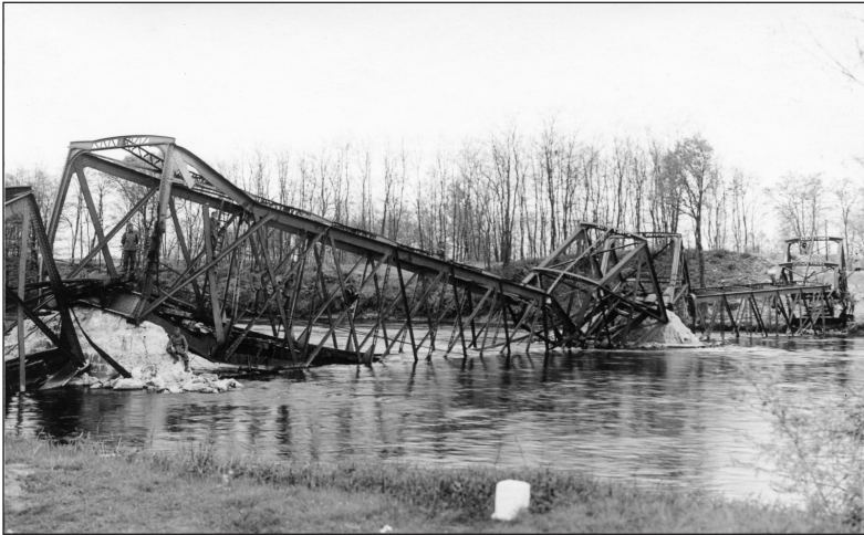
11. ábra Az első beton pilléreken álló helyiérdekű vasúti híd a Murán, 1941-ben (Forteapan, Karabélyos Péter)
