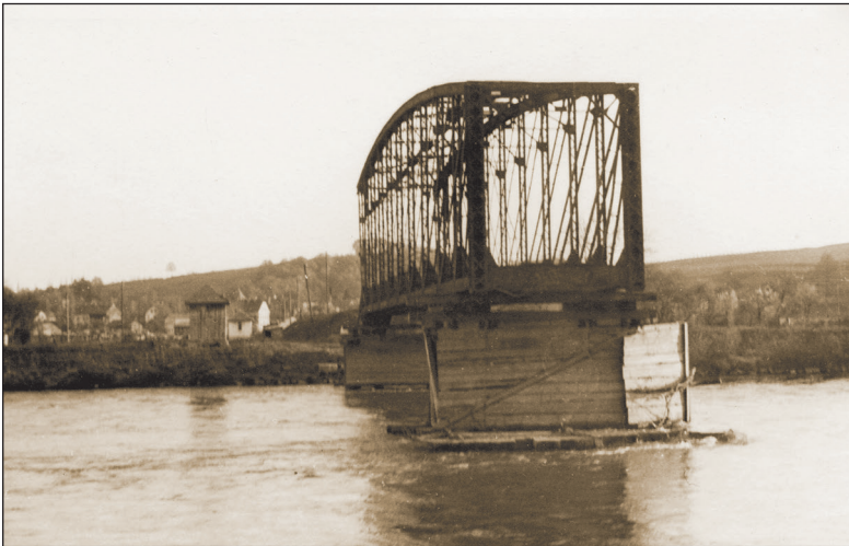
Az 1945. április 12-én felrobbantott vasúti Mura-híd maradványai.
