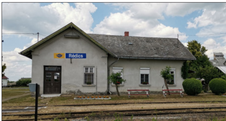
8. slika Stavba postaje Rédics danes, na kateri je dobro viden tip gradnje ob predaji: poslovni prostor, čakalnica, službeno stanovanje
