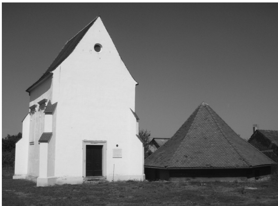
Slika 16: Samostan i mauzolej u Svetoj Jeleni
