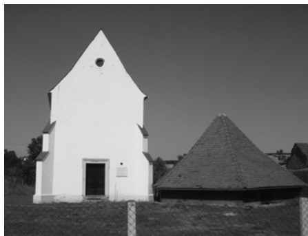
Slika 21: Samostan i mauzolej u Svetoj Jeleni
